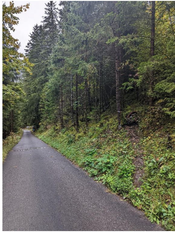
Abbildung 20: Zugangsweg zu Mundloch Dürrflue
